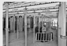
Casseforme per solai
