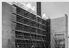
Impalcature di servizio
