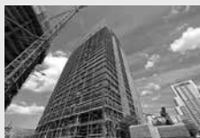
Ponteggi di facciata
