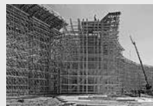
Impalcature di sostegno
