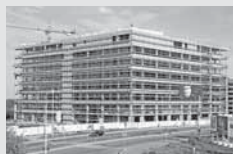
Ponteggi di facciata
