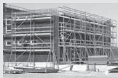
Impalcature di servizio
