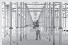
Casseforme per solai
