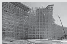
Impalcature di sostegno
