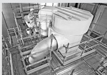
Impalcature di servizio per industria
