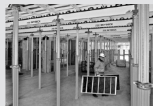
Casseforme per solai
