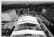
Impalcature di protezione
