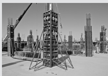
Casseforme per pilastri
