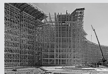
Impalcature di sostegno
