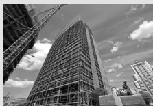
Impalcature di servizio per facciate
