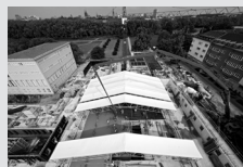
Impalcature di protezione
