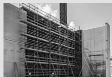
Impalcature di servizio per l'edilizia
