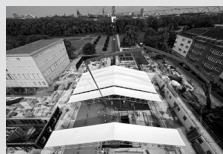
Impalcature di protezione
