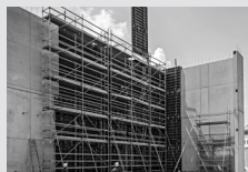
Impalcature per l'edilizia
