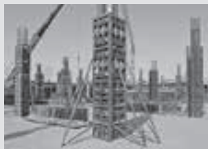
Casseforme per pilastri
