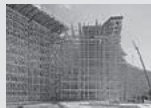
Impalcature di sostegno
