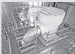
Ponteggi per l'industriale
