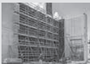
Impalcature di servizio
