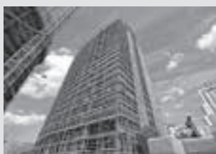
Ponteggi di facciata
