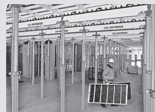
Casseforme per solai
