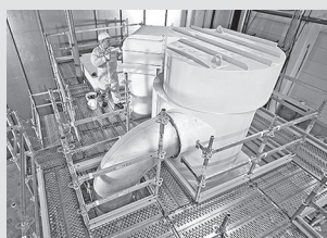
Impalcature di servizio per industria
