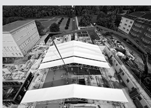
Impalcature di protezione
