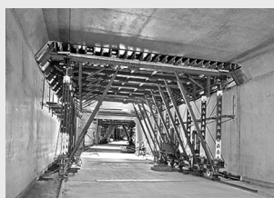
Cassaforma per tunnel
