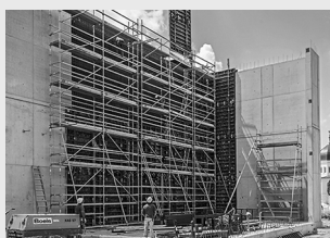
Impalcature per l'edilizia
