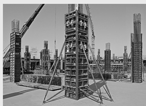
Cassaforma per pilastro
