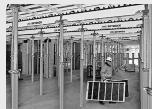
Cassaforma per solai
