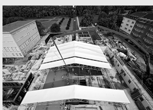
Impalcature di protezione
