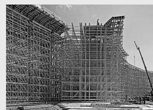
Sistemi di impalcature di sostegno
