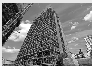
Impalcature per facciate
