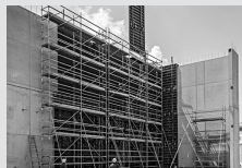
Impalcatura per costruzioni
