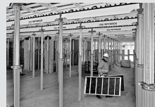
Cassaforma per solai
