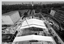
Impalcatura di protezione
