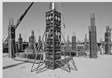
Cassaforma per pilastro
