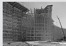
Sistemi di impalcature di sostegno
