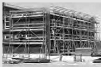
Impalcature di servizio
