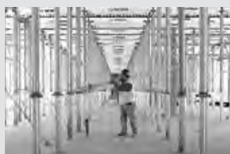
Casseforme per solai
