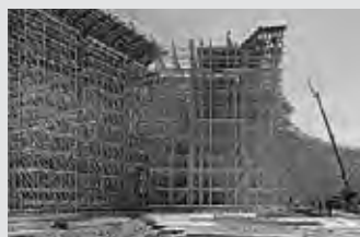
Impalcature di sostegno
