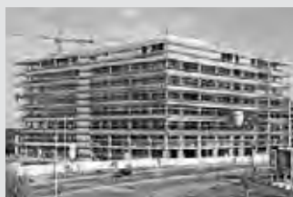
Ponteggi di facciata
