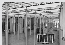
Casseforme per solai
