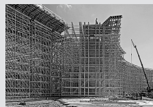
Impalcature di sostegno
