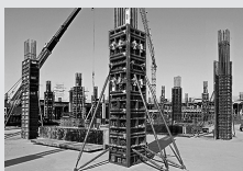
Casseforme per pilastri
