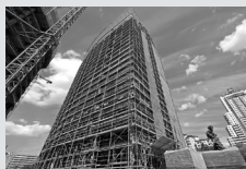
Ponteggi di facciata
