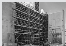
Impalcature di servizio
