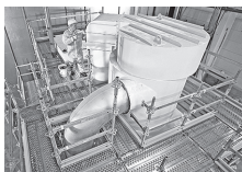
Impalcature di servizio per industria
