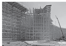
Impalcature di sostegno
