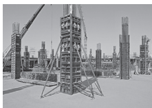
Casseforme per pilastri
