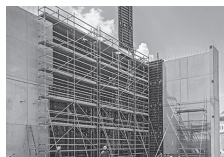
Impalcature di servizio per l'edilizia
