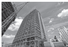
Impalcature di servizio per facciate
