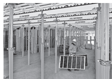
Casseforme per solai
