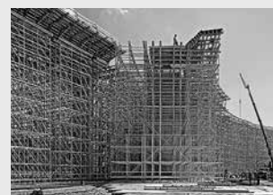
Impalcature di sostegno
