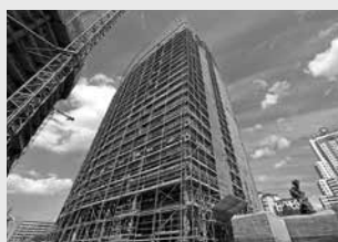
Ponteggi di facciata
