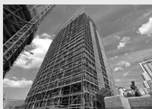
Ponteggi di facciata
