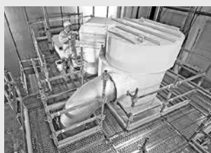
Ponteggi per l'industriale
