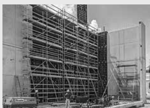
Impalcature di servizio
