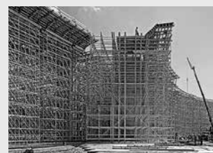
Impalcature di sostegno
