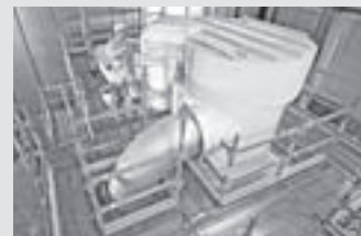
Ponteggi per l'industriale
