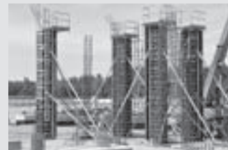
Casseforme per pilastri
