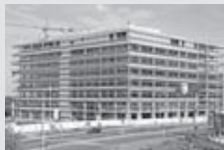
Ponteggi di facciata
