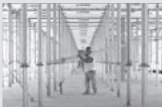
Casseforme per solai
