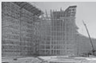
Impalcature di sostegno
