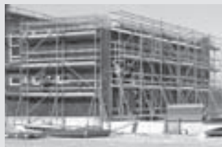
Impalcature di servizio
