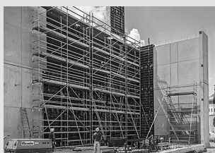
Impalcature di servizio per l'edilizia
