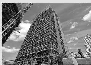
Impalcature di servizio per facciate
