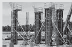
Casseforme per pilastri
