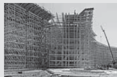
Impalcature di sostegno
