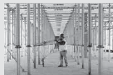
Casseforme per solai
