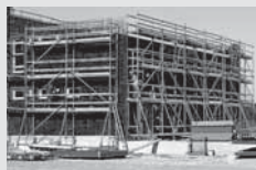
Impalcature di servizio
