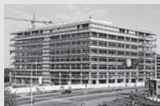
Ponteggi di facciata
