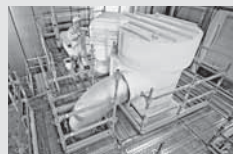
Ponteggi per l'industriale
