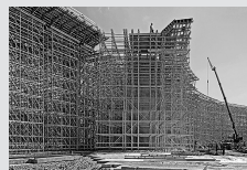
Impalcature di sostegno
