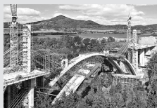
Casseforme per ponte
