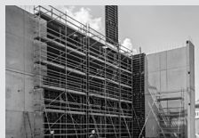
Impalcature di servizio per l'edilizia
