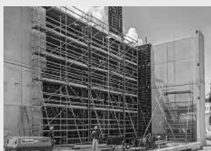
Impalcature di servizio
