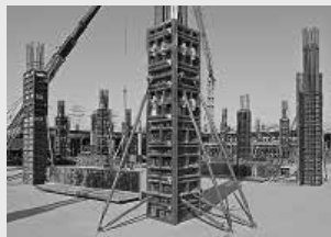
Casseforme per pilastri
