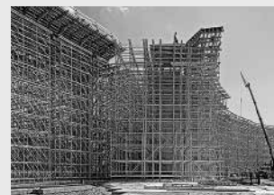
Impalcature di sostegno
