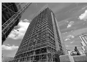
Ponteggi di facciata
