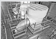
Impalcature di servizio per industria
