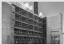
Impalcature di servizio per l'edilizia
