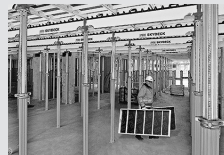
Casseforme per solai
