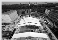
Impalcature di protezione
