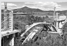
Casseforme per ponte
