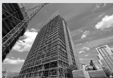
Impalcature di servizio per facciate
