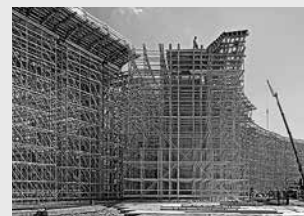
Impalcature di sostegno
