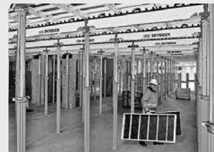
Casseforme per solai
