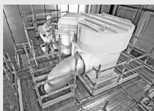
Ponteggi per l'industriale
