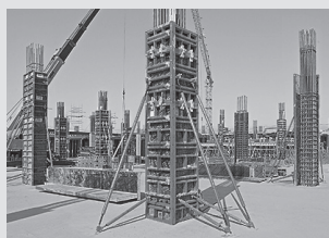
Cassaforma per pilastro
