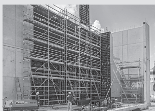
Impalcature per l'edilizia
