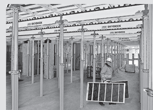
Cassaforma per solai
