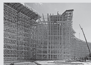
Sistemi di impalcature di sostegno
