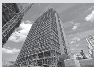
Impalcature per facciate
