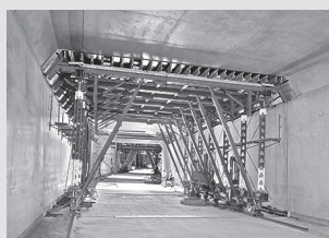
Cassaforma per tunnel
