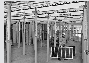
Casseforme per solai
