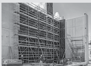
Impalcature di servizio
