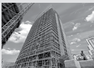
Ponteggi di facciata
