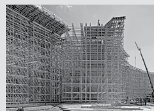
Impalcature di sostegno
