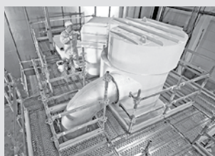
Ponteggi per l'industriale
