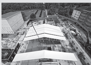
Impalcature di protezione
