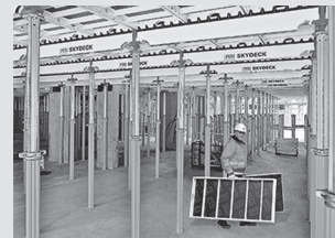
Casseforme per solai
