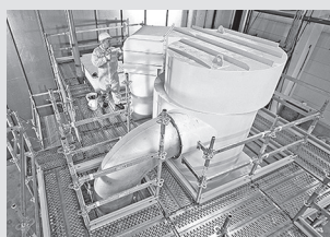
Impalcature di servizio per industria
