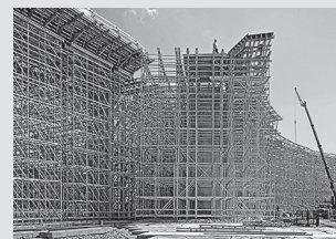
Impalcature di sostegno
