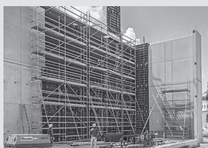
Impalcature di servizio per l'edilizia
