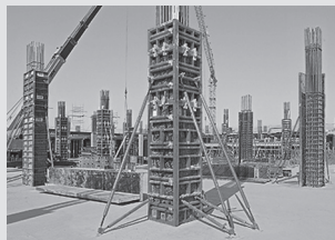
Casseforme per pilastri
