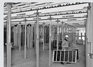
Casseforme per solai
