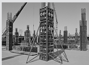
Casseforme per pilastri
