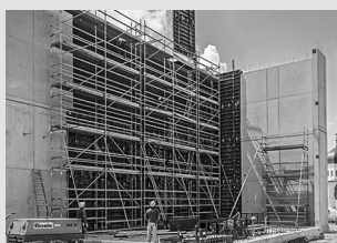
Impalcature di servizio per l'edilizia
