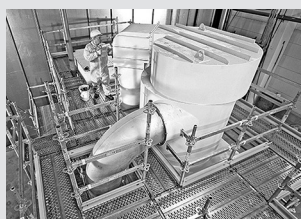
Impalcature di servizio per industria
