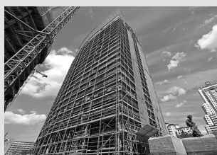
Impalcature di servizio per facciate
