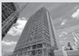
Ponteggi di facciata
