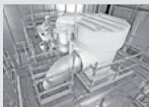
Ponteggi per l'industriale
