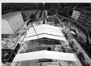
Impalcatura di protezione
