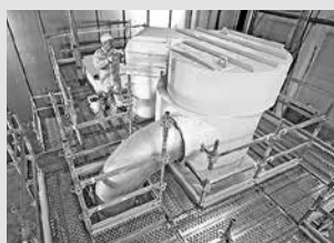
Ponteggi per l'industriale
