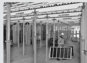
Casseforme per solai
