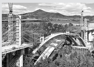
Casseforme per ponte
