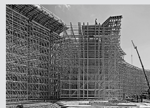
Impalcature di sostegno
