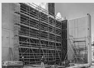
Impalcature di servizio
