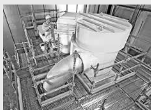
Ponteggi per l'industriale
