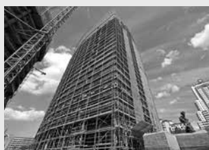
Ponteggi di facciata
