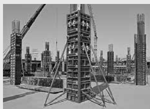
Casseforme per pilastri
