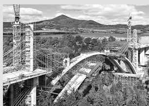
Casseforme per ponte
