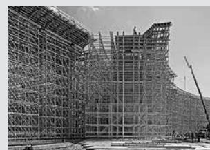
Impalcature di sostegno
