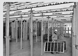
Casseforme per solai
