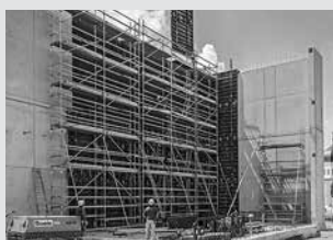
Impalcature di servizio
