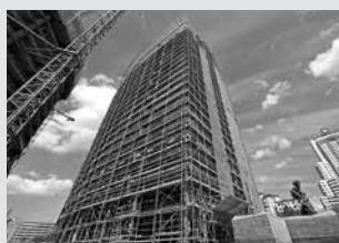
Ponteggi di facciata
