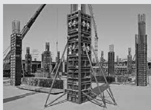
Casseforme per pilastri
