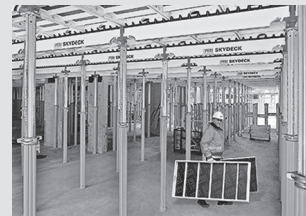
Casseforme per solai
