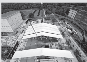
Impalcature di protezione
