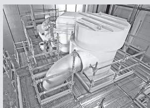
Impalcature di servizio per industria
