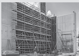
Impalcature di servizio per l'edilizia
