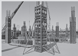
Casseforme per pilastri
