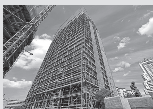
Impalcature di servizio per facciate
