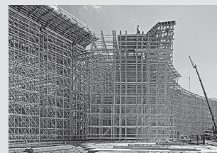
Impalcature di sostegno
