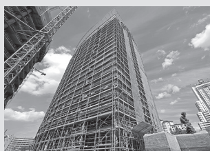
Impalcature per facciate
