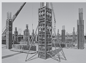
Cassaforma per pilastro
