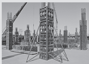
Casseforme per pilastri
