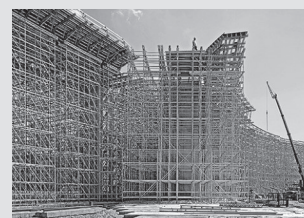
Impalcature di sostegno
