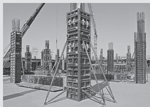
Cassaforma per pilastro
