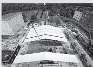
Impalcature di sicurezza
