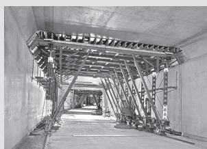
Cassaforma per tunnel
