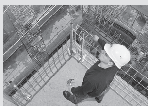
Sistemi di sicurezza
