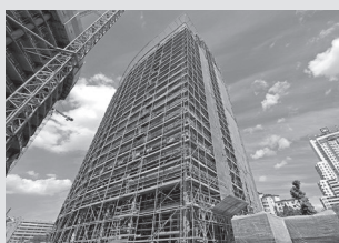
Impalcature di servizio per facciate
