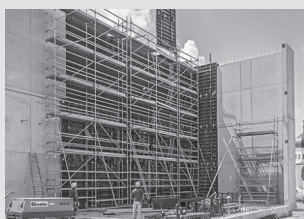
Impalcature di servizio
