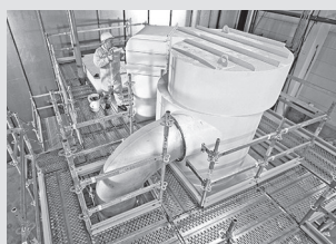
Impalcature di servizio per industrie
