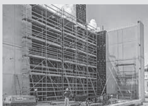
Impalcature di servizio
