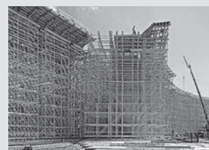
Impalcature di sostegno
