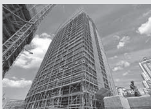
Ponteggi di facciata
