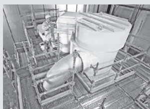
Ponteggi per l'industriale
