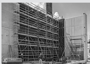
Impalcature di servizio per l'edilizia
