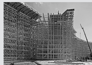
Impalcature di sostegno
