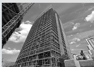
Impalcature di servizio per facciate
