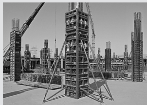
Casseforme per pilastri
