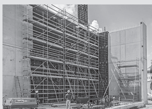
Impalcature per l'edilizia
