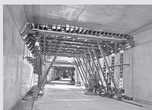
Cassaforma per tunnel
