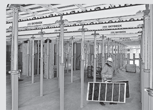
Cassaforma per solai
