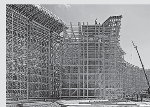
Impalcature di sostegno
