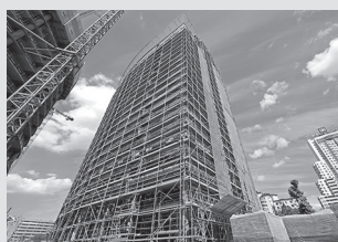
Impalcature per facciate
