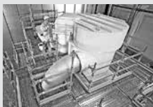
Ponteggi per l'industriale
