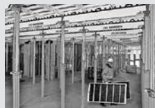
Casseforme per solai
