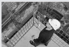
Sistemi di sicurezza
