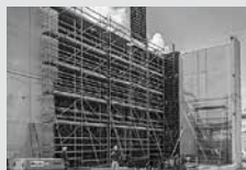
Impalcature di servizio
