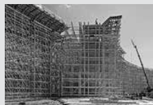
Impalcature di sostegno
