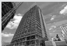
Ponteggi di facciata
