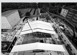
Impalcature di protezione
