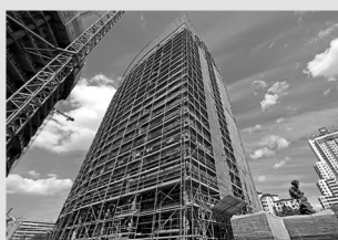
Impalcature di servizio per facciate
