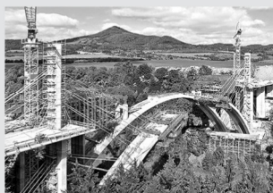
Casseforme per ponte
