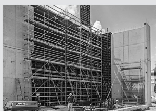
Impalcature di servizio per l'edilizia
