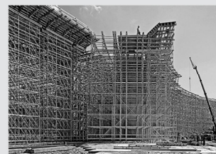
Impalcature di sostegno
