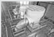
Ponteggi per l'industriale
