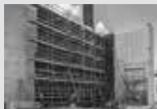
Impalcature di servizio
