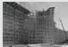
Impalcature di sostegno
