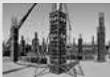
Casseforme per pilastri
