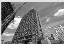
Impalcature di servizio per facciate
