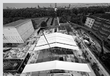
Impalcature di protezione
