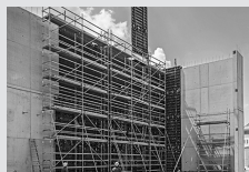
Impalcature di servizio per l'edilizia
