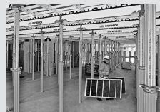
Casseforme per solai
