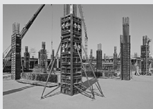
Casseforme per pilastri
