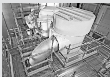
Impalcature di servizio per industria
