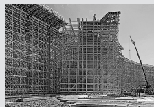
Impalcature di sostegno
