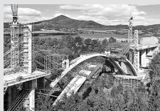
Casseforme per ponte
