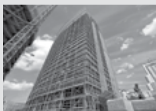
Ponteggi di facciata
