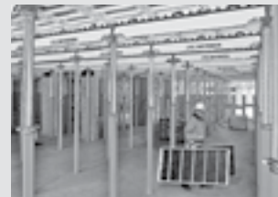
Casseforme per solai
