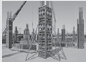
Casseforme per pilastri
