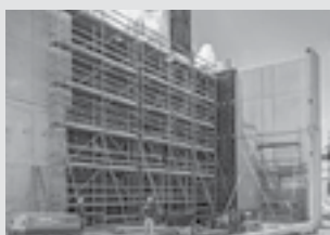
Impalcature di servizio
