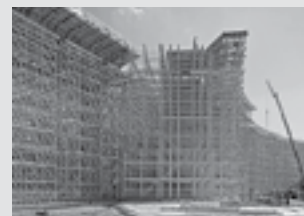
Impalcature di sostegno
