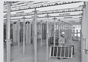
Cassaforma per solai
