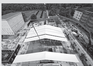
Impalcature di protezione
