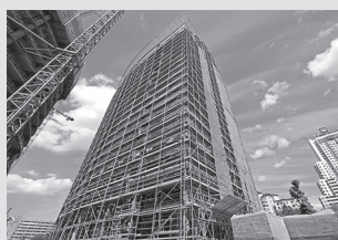
Impalcature per facciate
