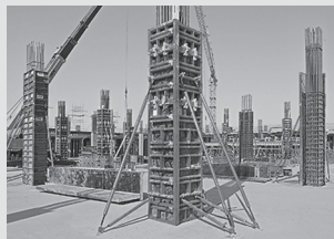
Casseforme per pilastri
