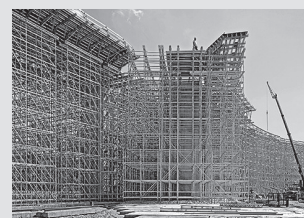
Impalcature di sostegno
