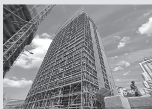
Impalcature per facciate
