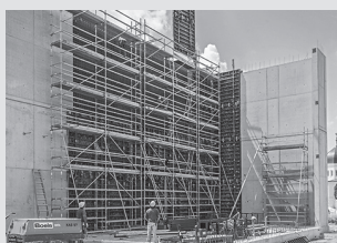
Impalcature per l'edilizia
