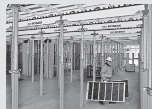
Cassaforma per solai
